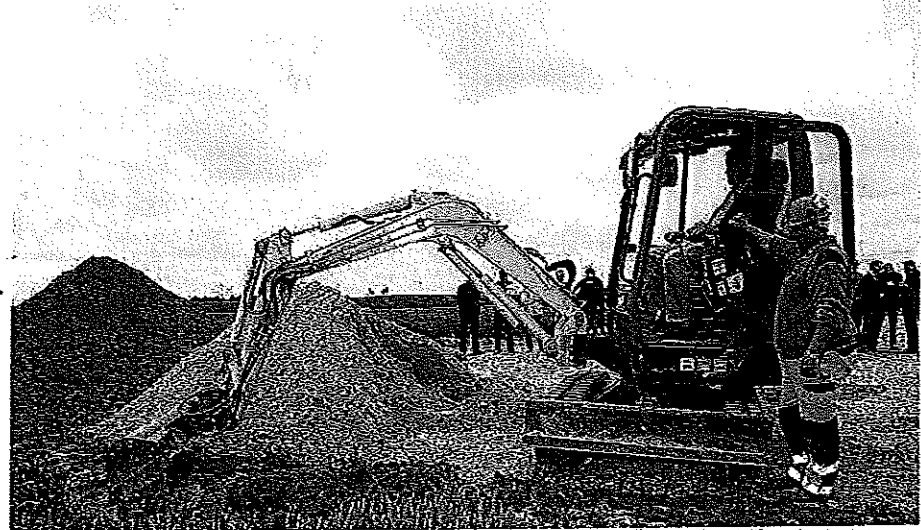
Verbandsvorsteher Hans-Rudolf Heinsohn: Spatenstich mit Bagger.
