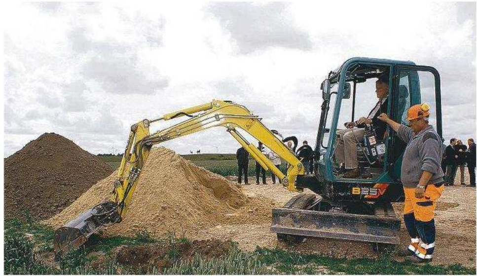
Verbandsvorsteher Hans-Rudolf Heinsohn: Spatenstich mit Bagger.
