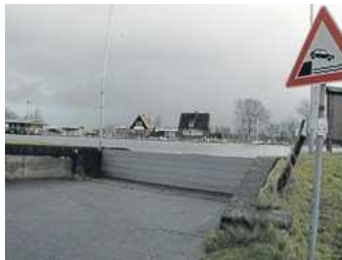
Angespannte Lage an der Eider bei Tielenhemme. Die Stöpe ist bereits verschlossen, um das Binnenland vor einer Überflutung zu schützen. Foto: Tiessen
