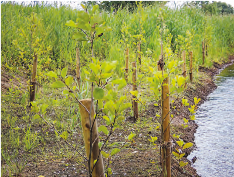
Abb. 7: Am Böschungsfuß wachsende Jungerlen. Hier können die Wurzeln später strukturell wirksam werden, Habitate bilden und das Ufer sichern.
