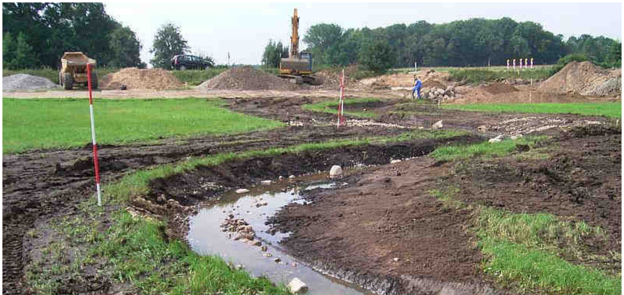
Bild 6: Herstellung des neuen Gewässers
