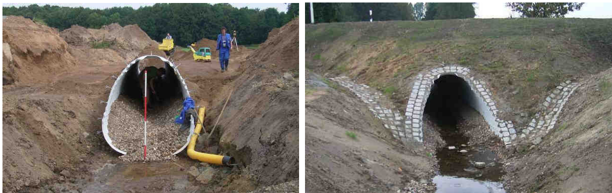
Bild 4: Herstellung Straßendurchlass, links: Bauzustand, rechts: fertiggestellter Durchlass
